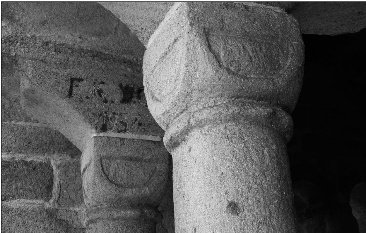
Obr. 18: Svojšíň (okr. Tachov), kostel sv. Petra a Pavla. Detail hlavic románského okna v jižní zdi věže (foto M. Falta 2008).
