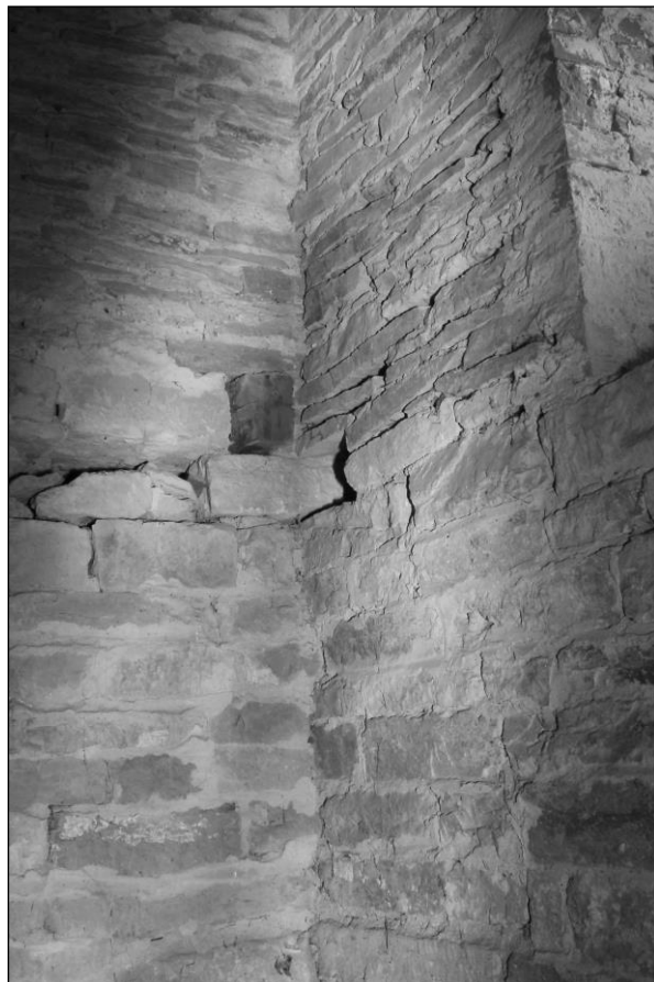
Obr. 75 (vlevo): Vysoký Újezd nad Dědinou (okr. Hradec Králové), kostel sv. Jakuba Většího. Pohled na východní stěnu věže s románským portálem v úrovni podkroví lodi (foto M. Falta 2011).
