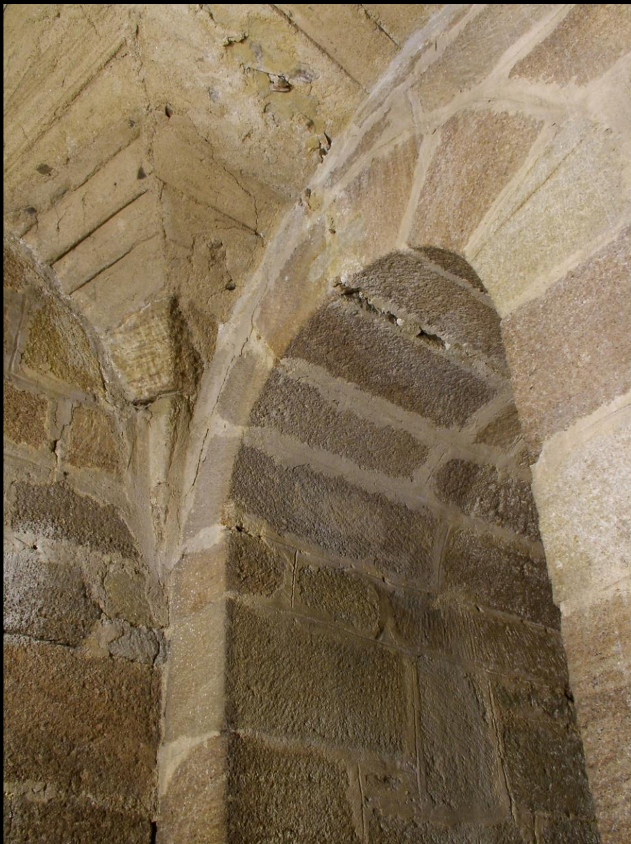
Přízemní prostor věže – vstupní portál, detail konzoly, klenebního pasu a části šalování křížové klenby.
