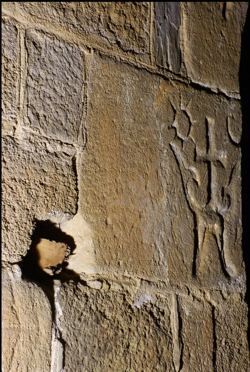
Detail nároží věže se zbytkem lešení v dnešním podkroví, klasový motiv na zdivu a otisk někdejšího štítu lodi.
