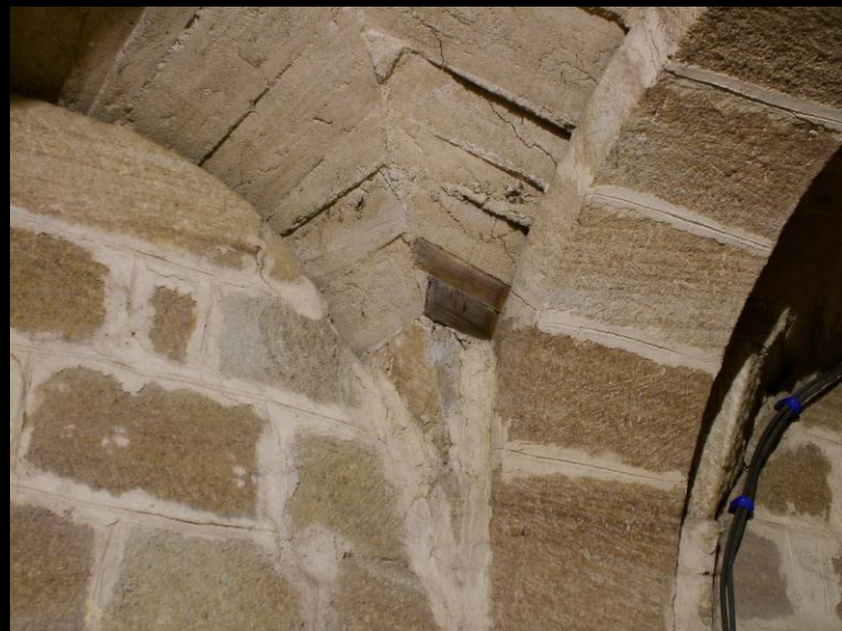
Přízemní prostor věže – vstupní portál, detail konzoly, klenebního pasu a části šalování křížové klenby.
