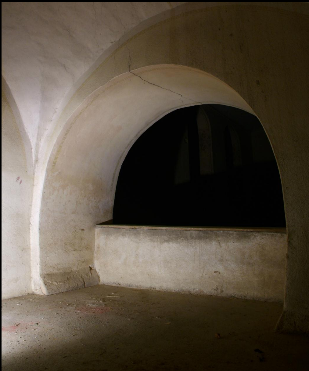
Empora v patře věže.
