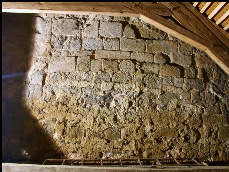
Detail nároží věže se zbytkem lešení v dnešním podkroví, klasový motiv na zdivu a otisk někdejšího štítu lodi.
