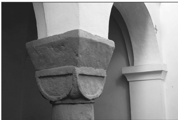
Obr. 4: Vysoký Újezd nad Dědinou (okr. Rychnov nad Kněžnou), kostel sv. Jakuba Většího. Krychlová hlavice nesoucí arkády empory (foto M. Falta 2011).
