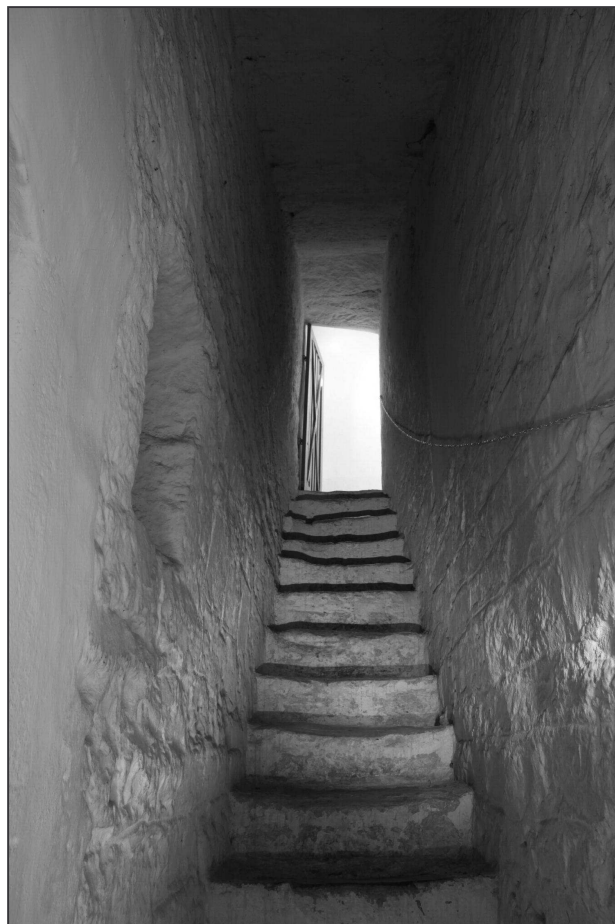
Obr. 6: Vysoký Újezd nad Dědinou (okr. Rychnov nad Kněžnou), kostel sv. Jakuba Většího. Schodiště spojující loď a emporu vedené v tloušťce jižního rizalitu (foto M. Falta 2011).
