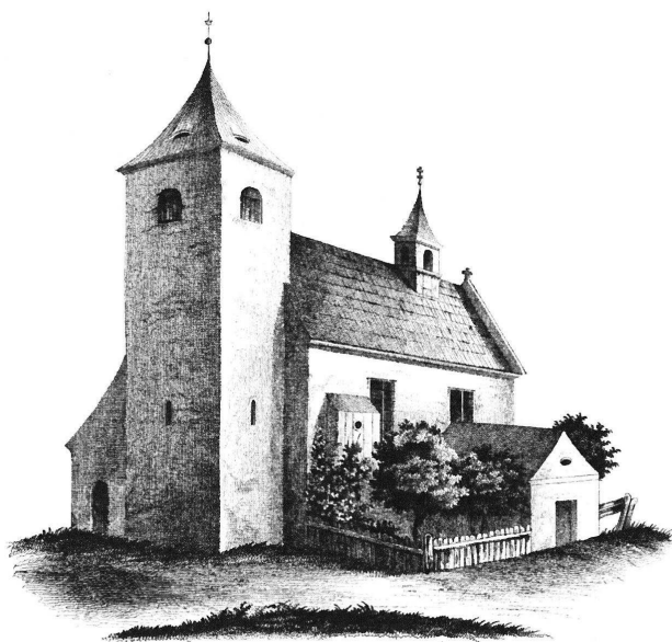
Obr. 2: Vysoký Újezd nad Dědinou (okr. Rychnov nad Kněžnou), kostel sv. Jakuba Většího. Celkový pohled na kostel od jihozápadu v r. 1857 (kresba H. Toman 1857, viz pozn. 7, tab 13).
