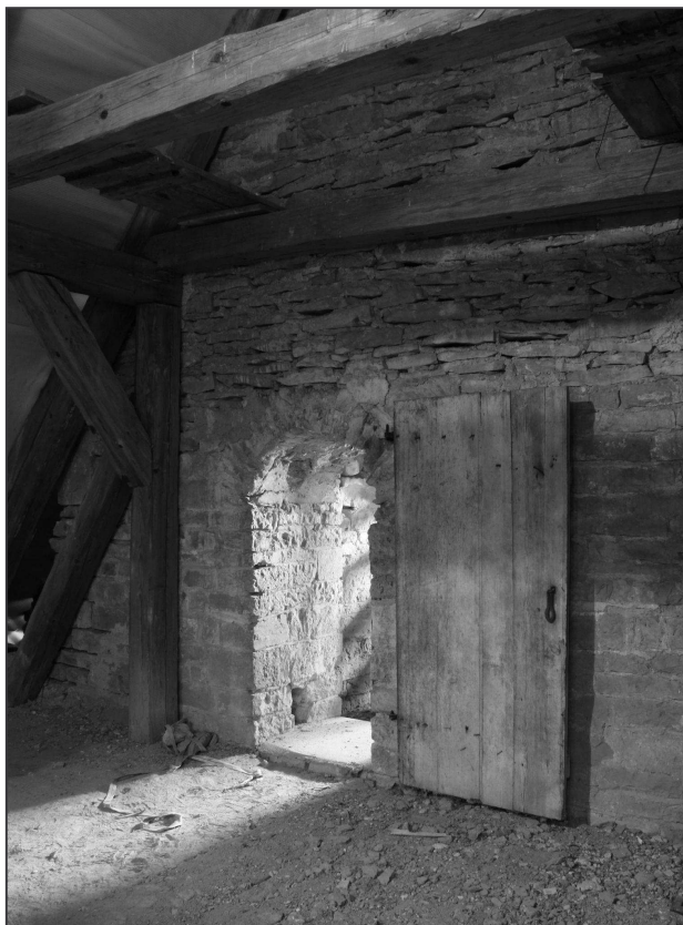
Obr. 7: Vysoký Újezd nad Dědinou (okr. Rychnov nad Kněžnou), kostel sv. Jakuba Většího. Pohled na východní stěnu věže s románským portálem v úrovni podkroví lodi (foto M. Falta 2011).
