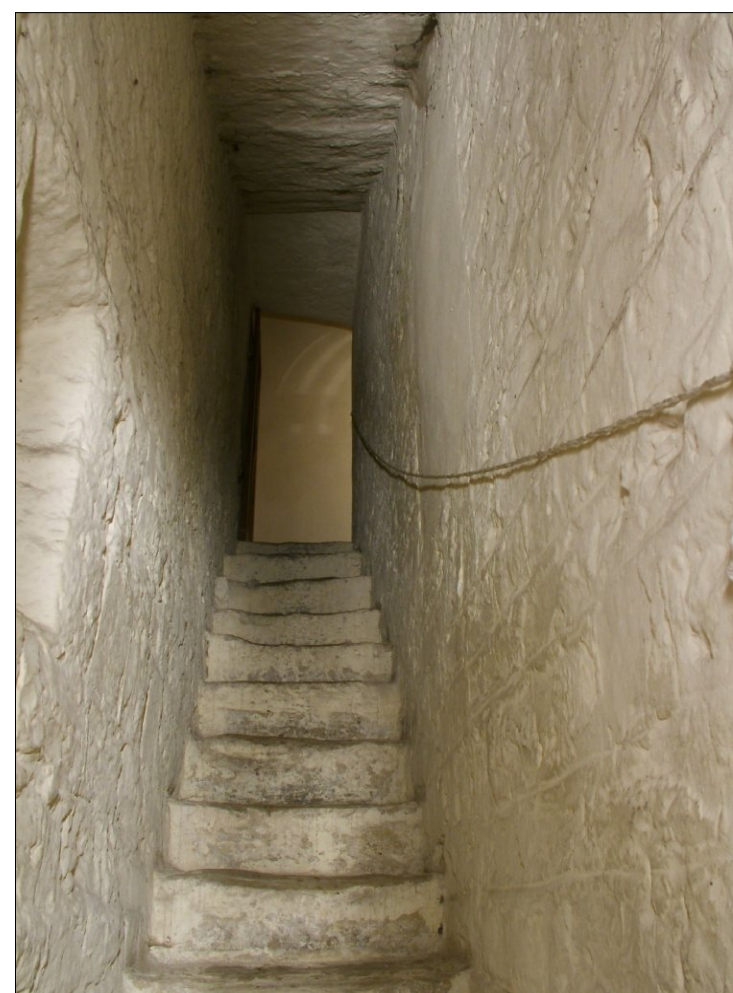
SCHODIŠTĚ V JIŽNÍM RIZALITU
