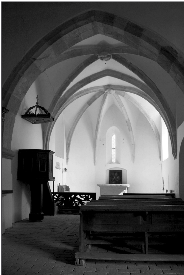
Obr. 5: Vícov (okr. Plzeň-jih), kostel sv. Ambrože. Pohled do východní části chrámu (foto M. Falta 2017).
