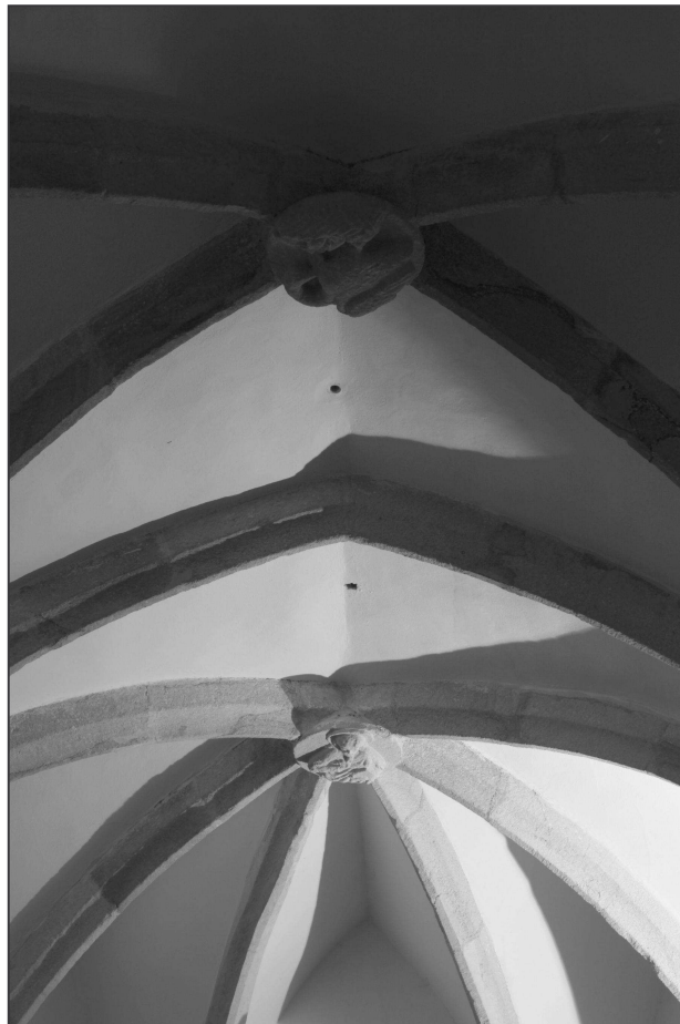
Obr. 6: Vícov (okr. Plzeň-jih), kostel sv. Ambrože. Detail gotických svorníků klenby presbyteria (foto M. Falta 2013).
