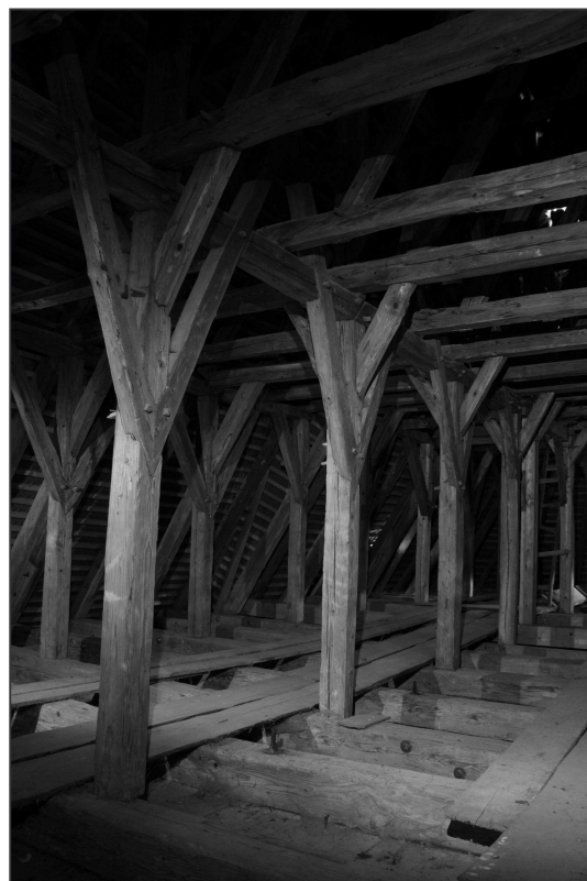
Obr. 15: Vícov (okr. Plzeň-jih), kostel sv. Ambrože. Průhled gotickým krovem (foto M. Falta 2017).
